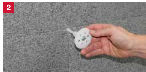
Insertion manuelle de la cheville (avec vis pré-montée) jusqu'à ce que la rosace repose sur l'isolant
