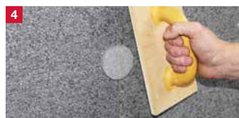
Mise en place de la rondelle ejotherm STR à fleur de l'isolant à l'aide d'une lisseuse. C'est terminé !
